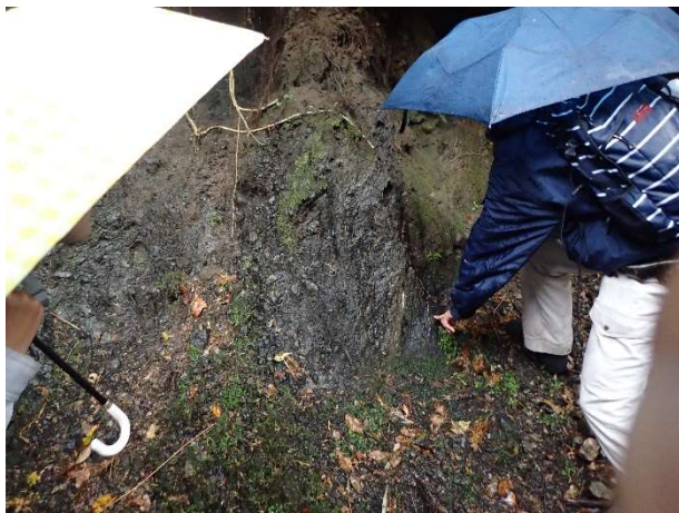
図 52 根尾谷断層破碎帯 日当駅東
